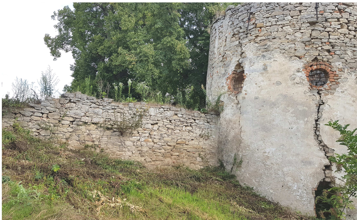
FOT. 7 Mur graniczny od strony południowej w kierunku wschodnim
