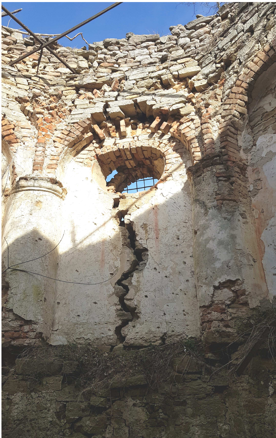
FOT. 15 Widok ścian od wewnątrz w osiach 3 — 4
