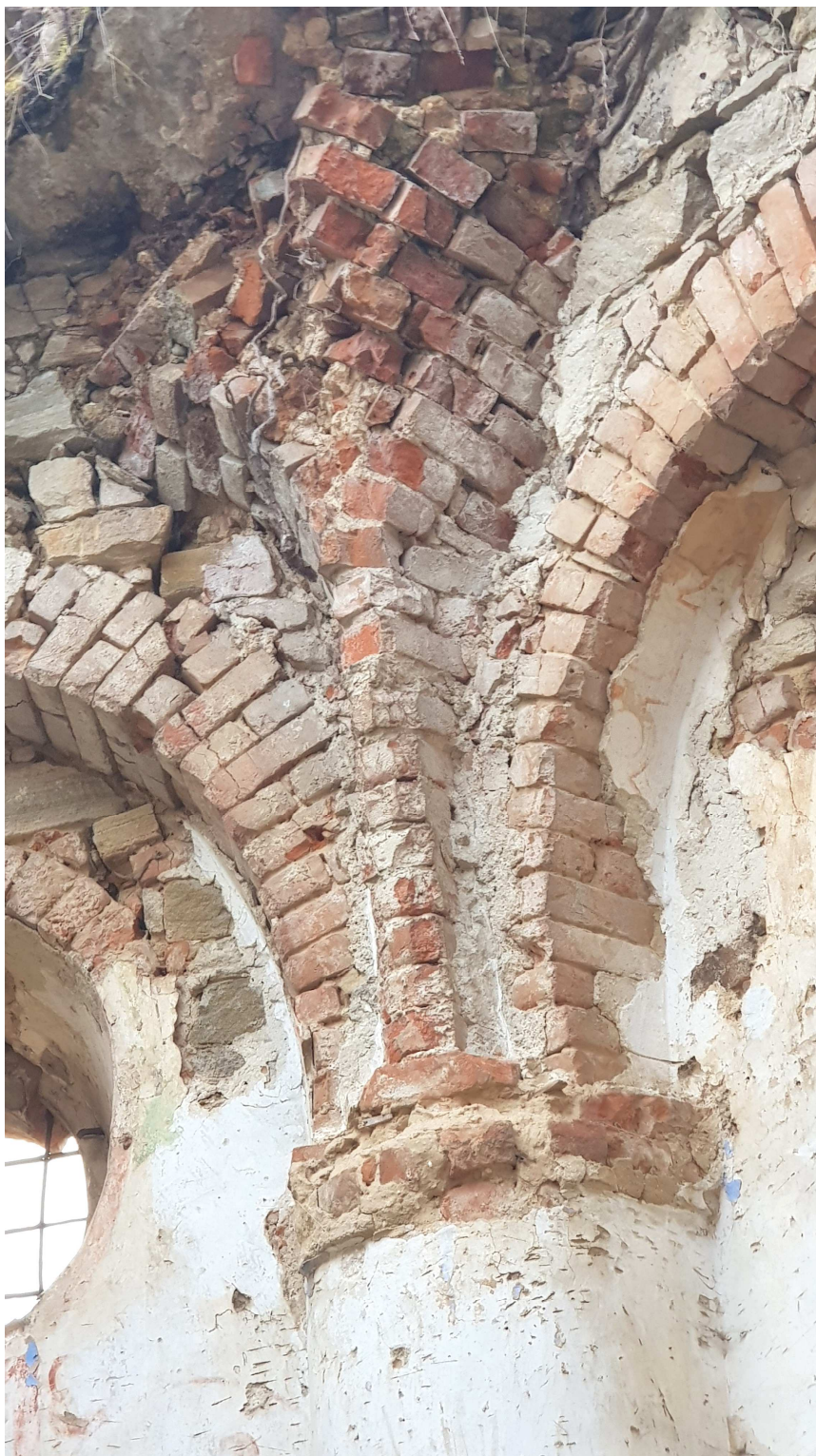
FOT. 21 Służka żebrowego sklepienia wielobocznego z lunetami i łęki przysklepienne w osi 7
