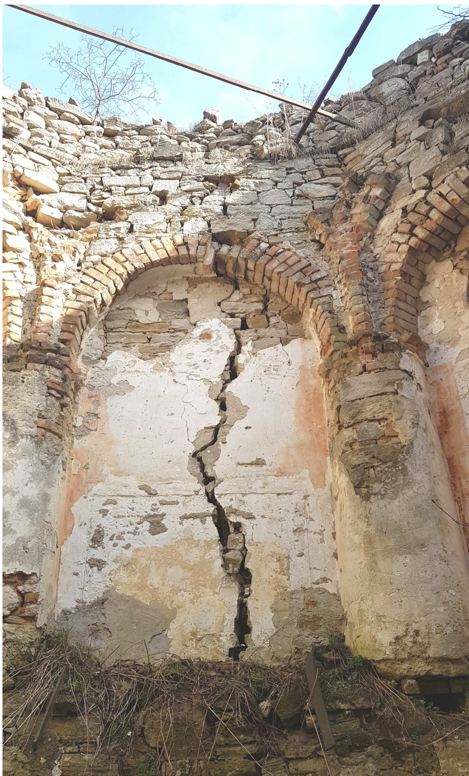
FOT. 16 Widok ścian od wewnątrz w osiach 4 — 5
