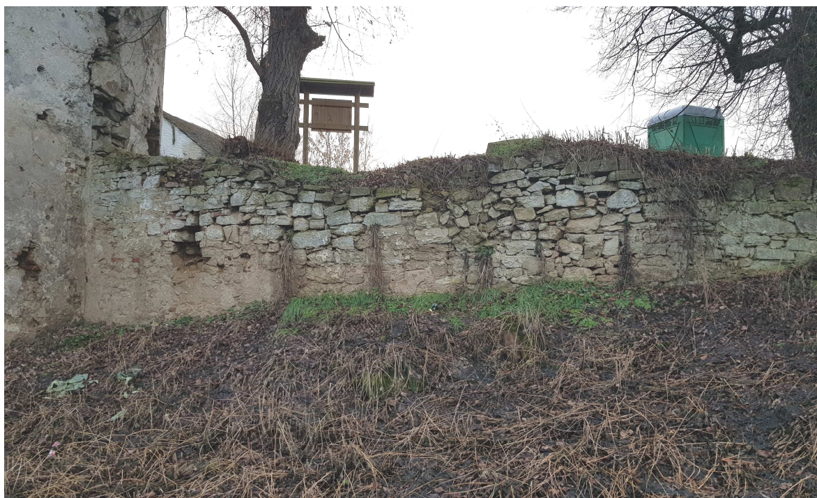
FOT. 6 Mur graniczny od strony wschodniej w kierunku północy
