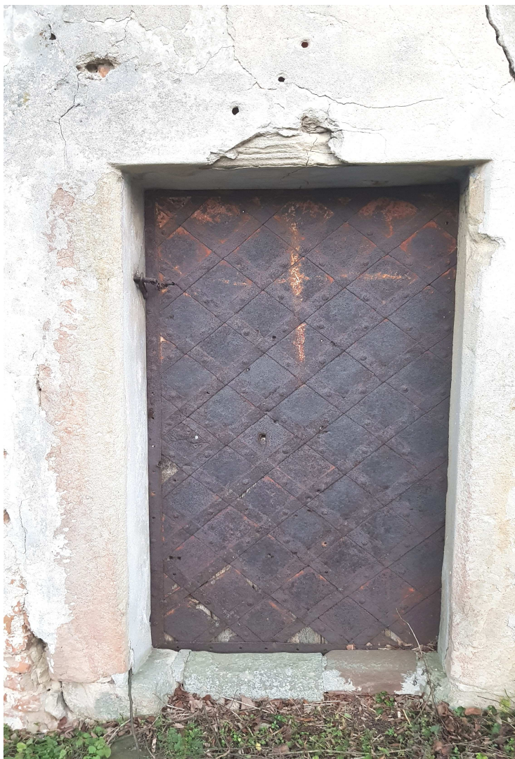
FOT. 8 Drzwi spągowe okute blachą – stan zachowania 2022
