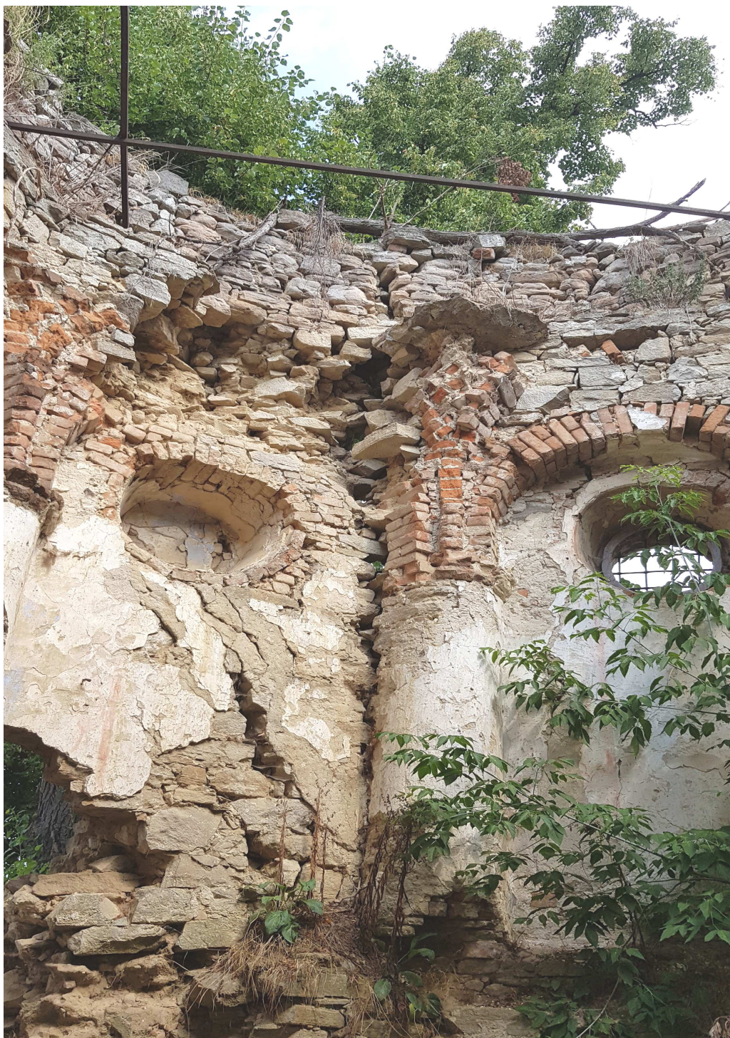
FOT. 12 Widok ścian od wewnątrz w osiach 1 — 2 — 3
