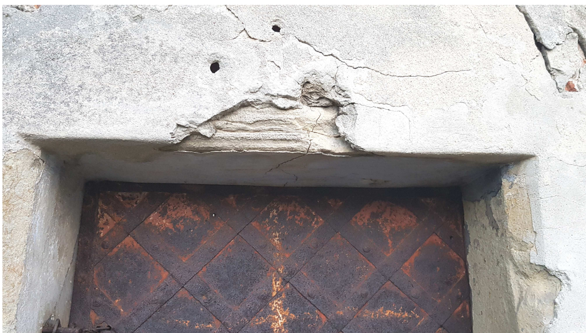
FOT. 9 Detal kamienny drzwi od strony elewacji
