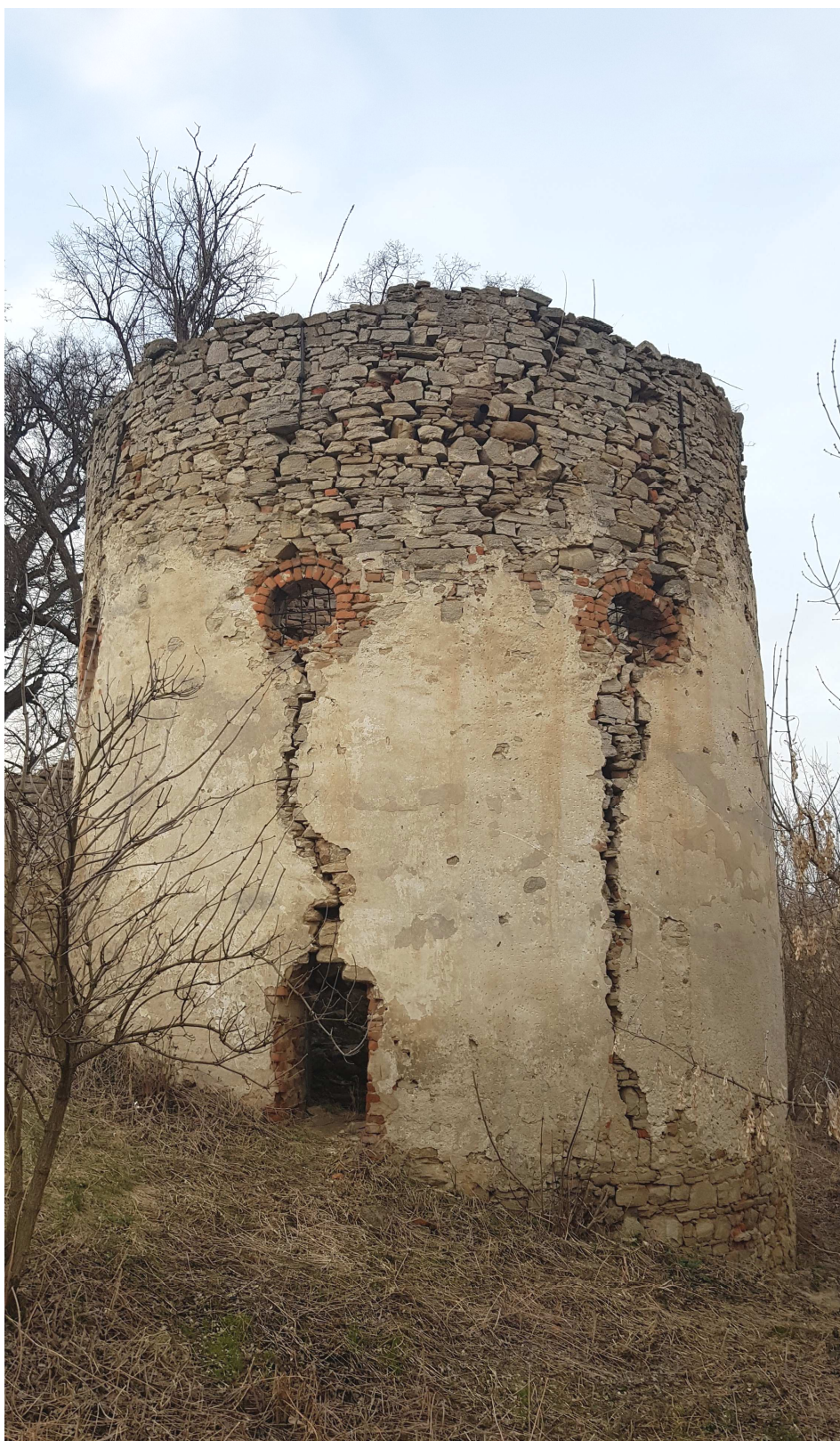
FOT. 3 Widok elewacji od strony południowej
