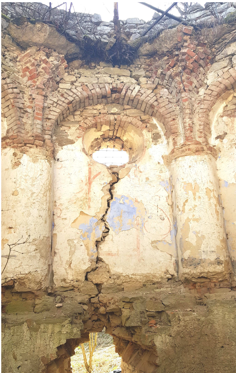
FOT. 18 Widok ścian od wewnątrz w osiach 6 — 7
