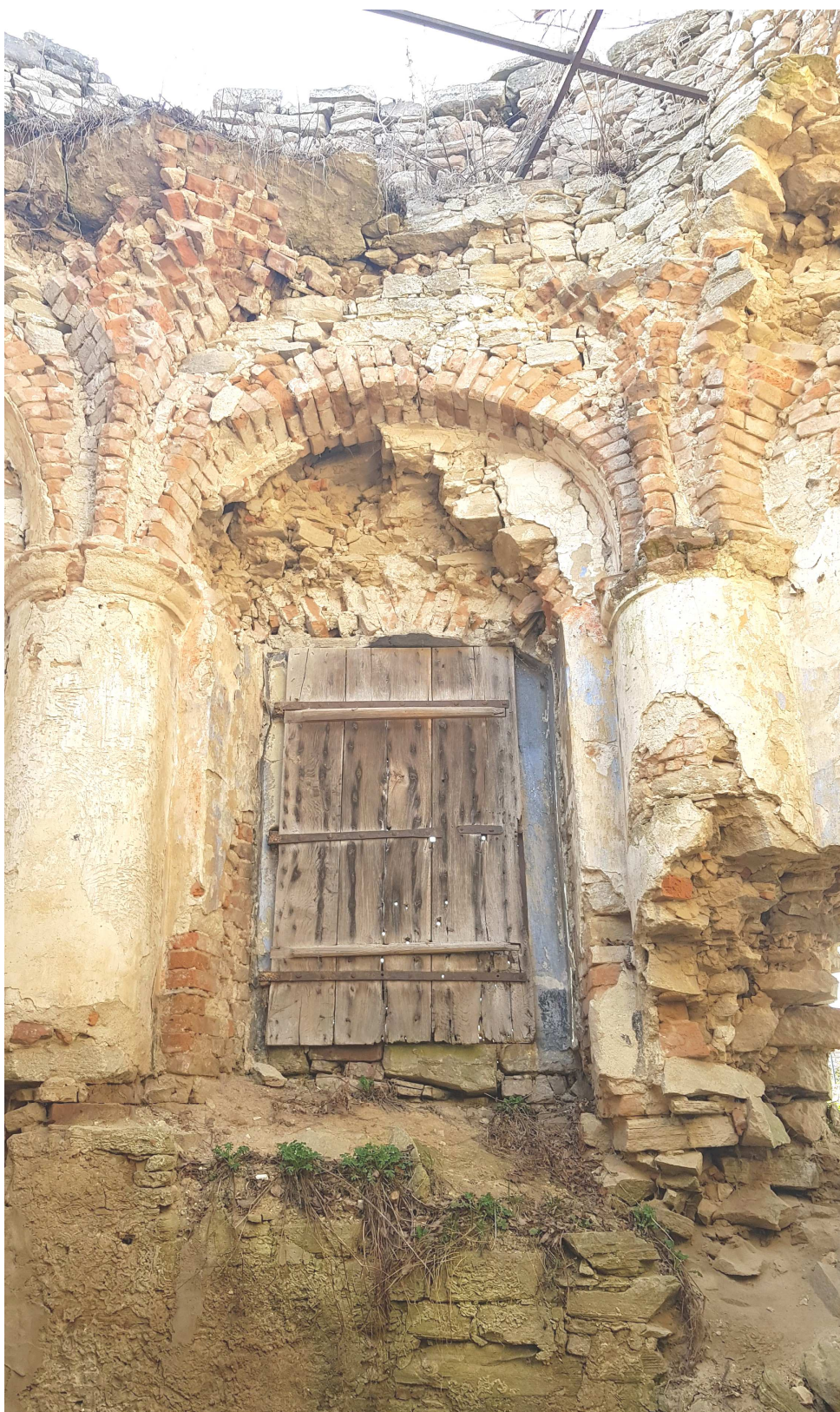
FOT. 20 Widok ścian od wewnątrz w osiach 8 — 1
