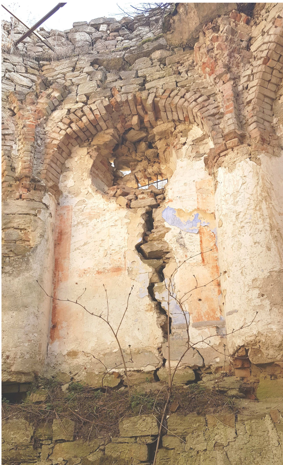
FOT. 17 Widok ścian od wewnątrz w osiach 5 — 6
