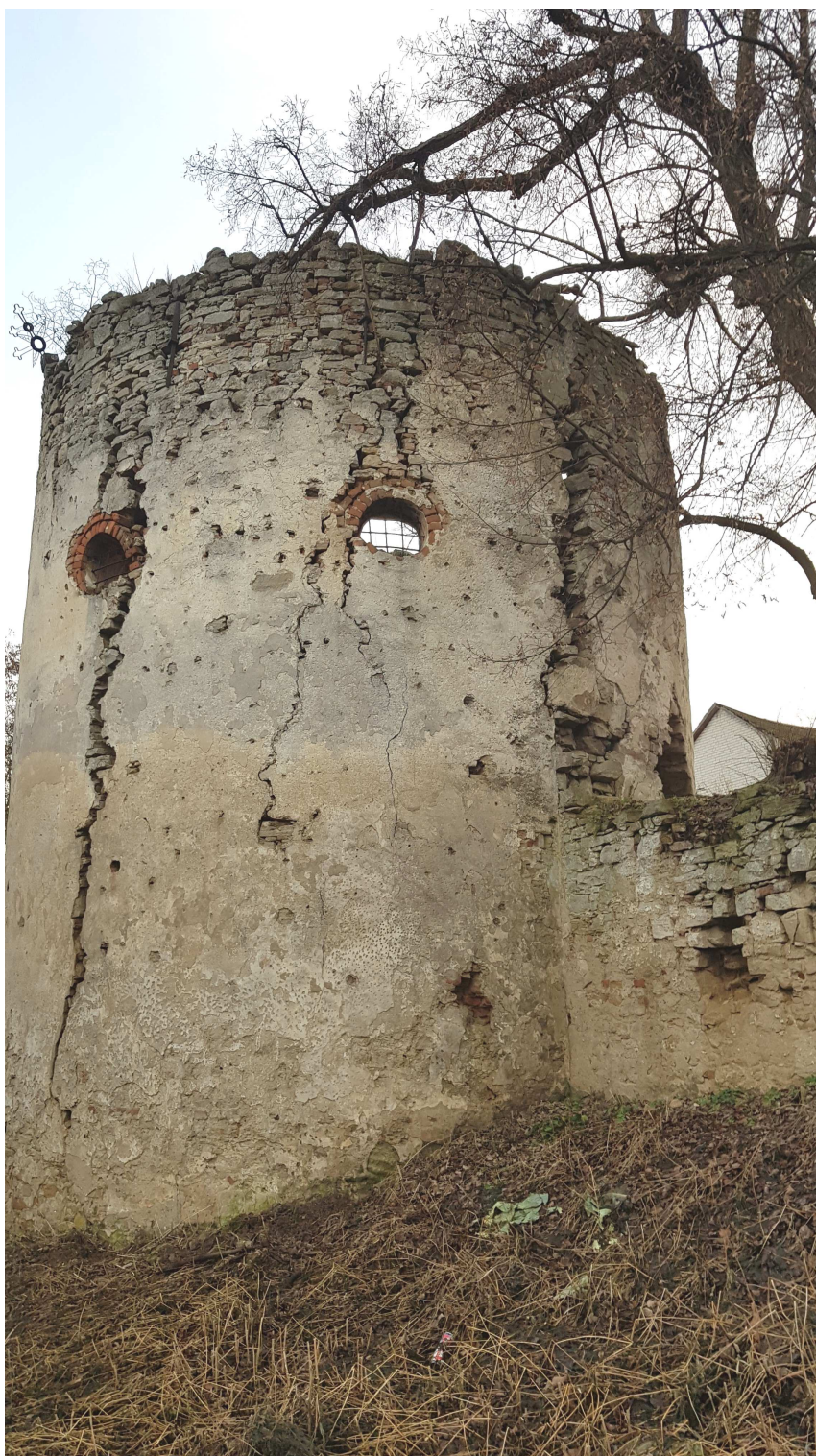
FOT. 5 Widok elewacji od strony północnej
