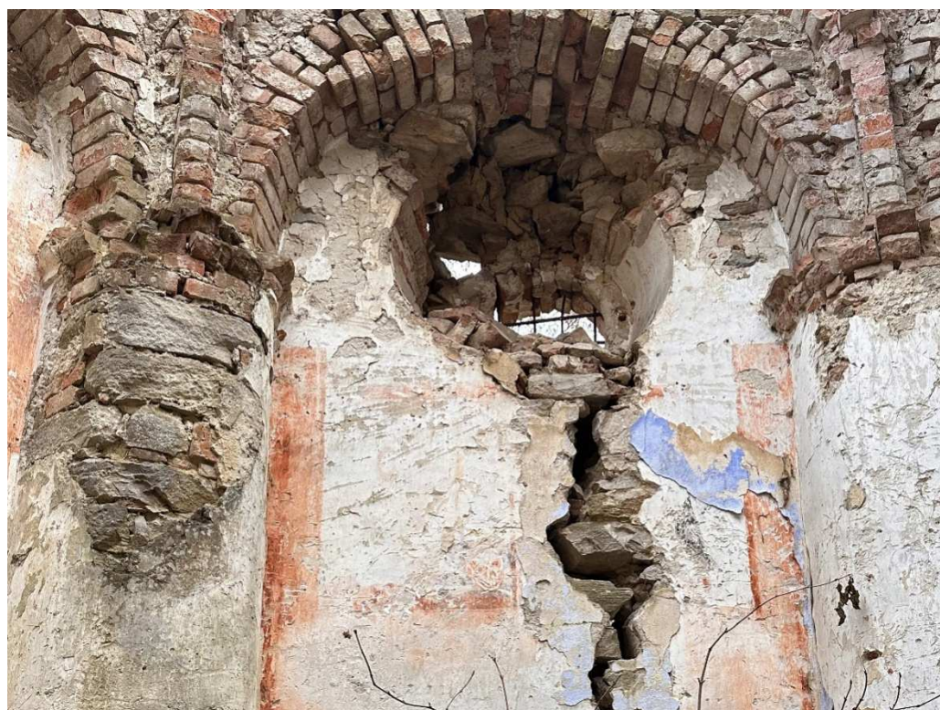
Fot nr 6 XVII wieczna baszta dworu obronnego w Kicharach. Widok stanu istniejącego miejscowo zachowanych polichromii ściennych.
