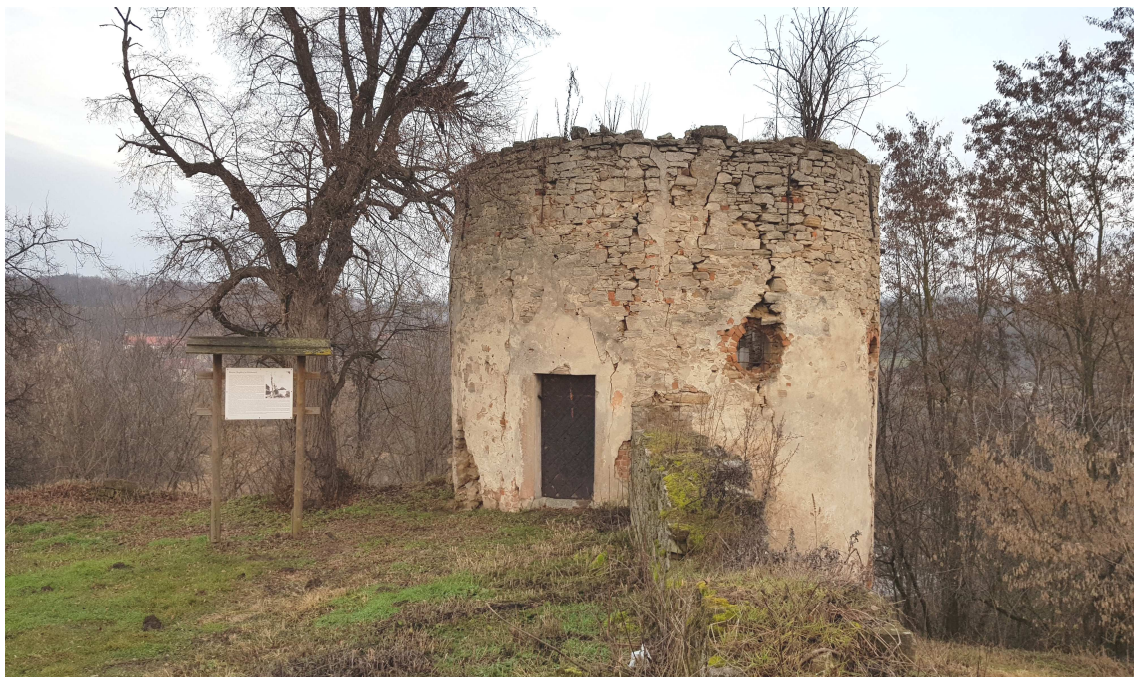
FOT. 1 Widok elewacji frontowej od strony zachodniej
