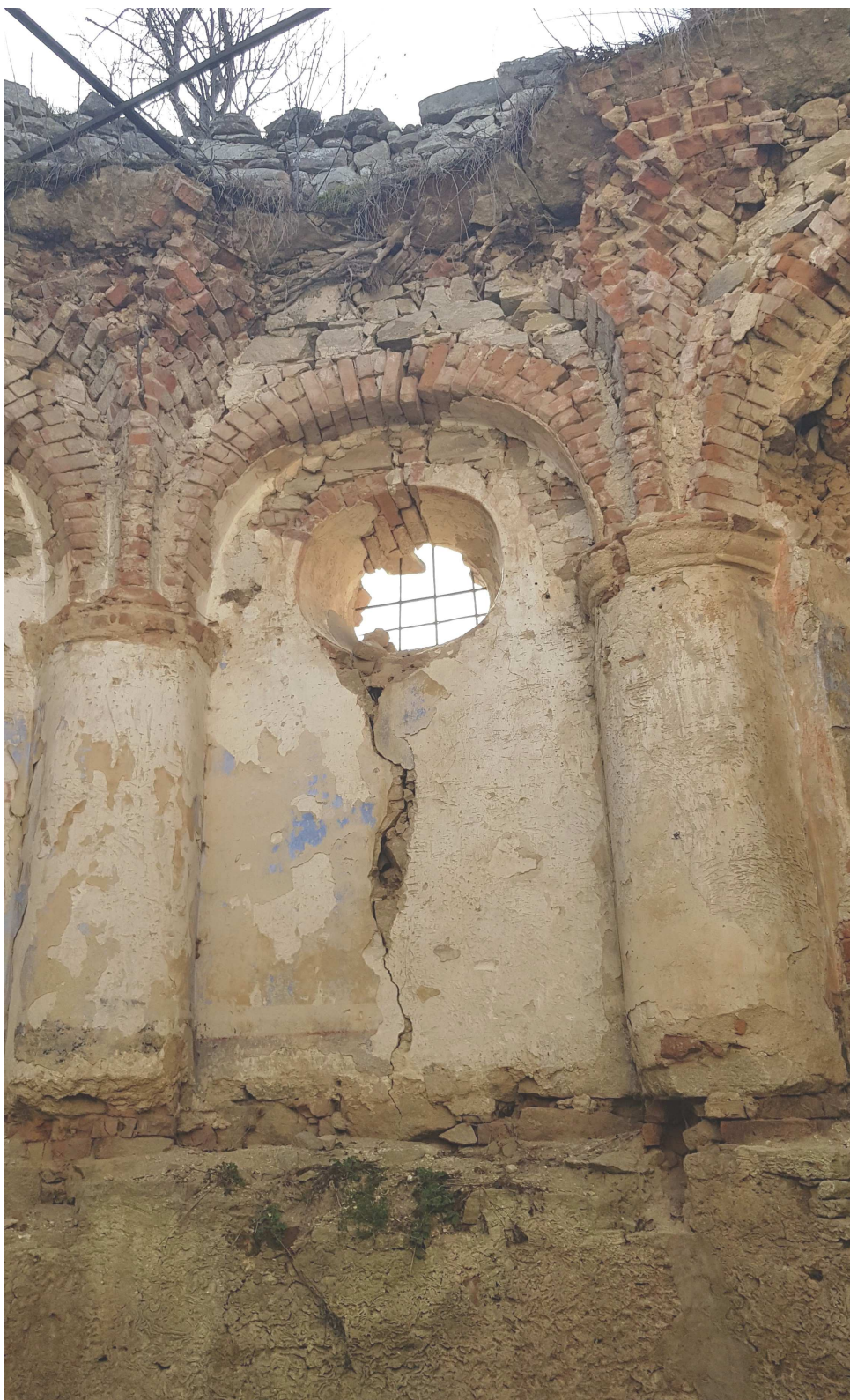
FOT. 19 Widok ścian od wewnątrz w osiach 7 — 8
