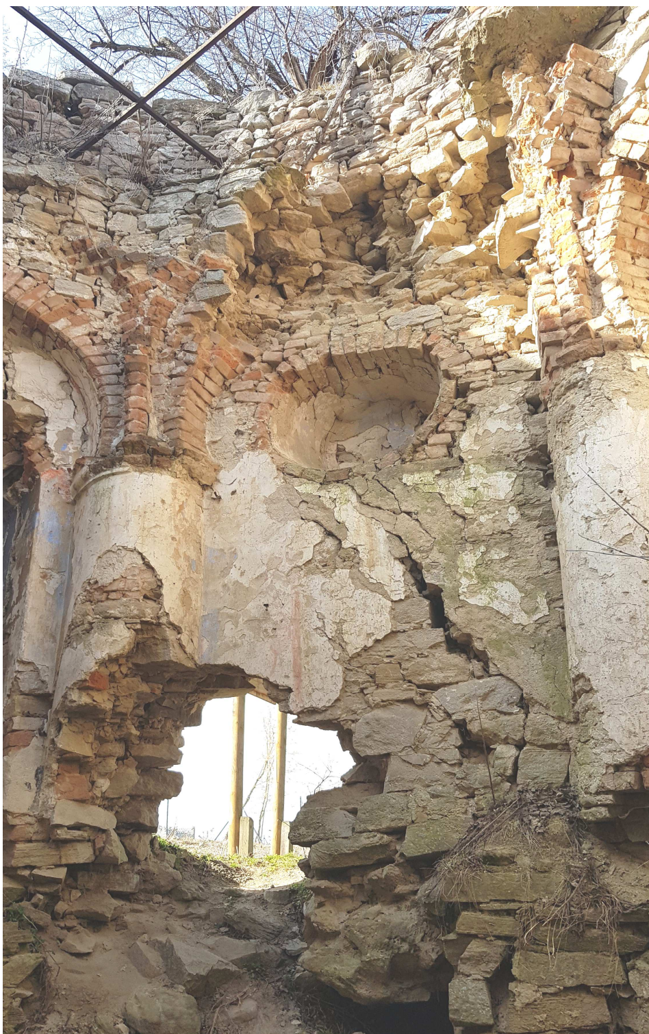
FOT. 13 Widok ścian z rozebrany murem od wewnątrz w osiach 1 — 2
